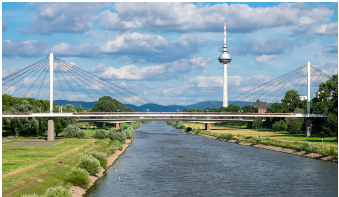
Blick über den Neckar auf den Fernsehturm Mannheim
